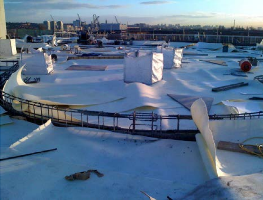
6. Pod 4 TH Floor Pour Frost Protection: 25 th November 2010
